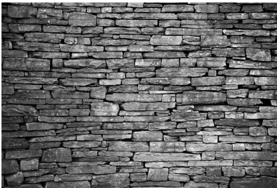
Mur en pierre sèche
