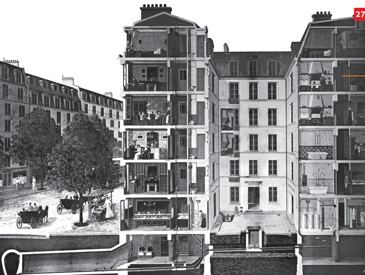
Coupe d'une maison montrant l'installation du tout-à-l'égout à Paris, vers 1900.
